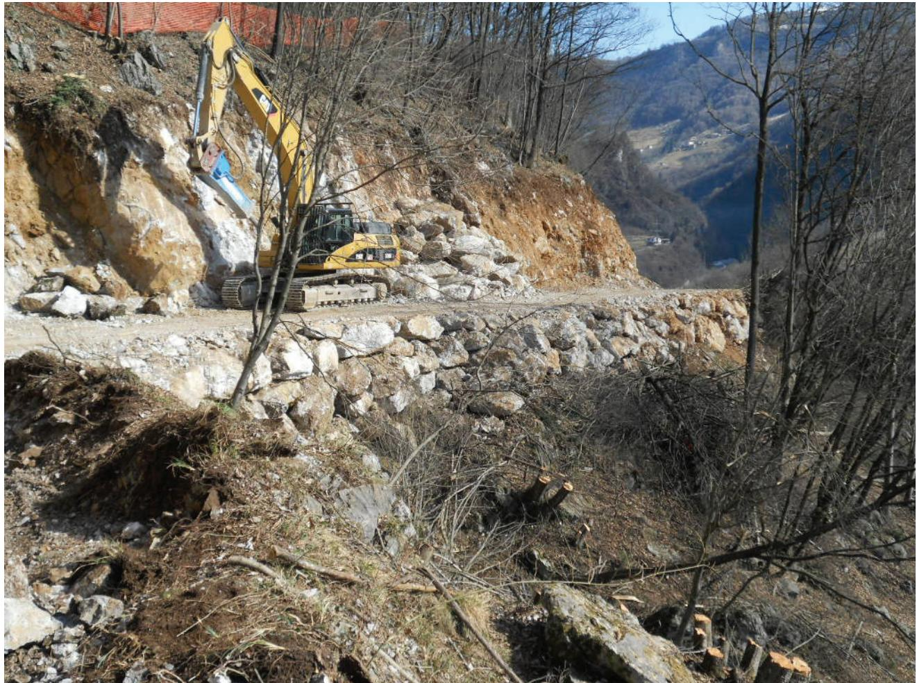
Le opere in corso consistono nell'esecuzione di una pista di penetrazione per raggiungere l'imbocco nord della galleria Monte di Zogno. Il lavoro si sviluppa per avanzamenti successivi. La pista è realizzata in terreno parzialmente roccioso e sciolto, ripulito dal legname in avanzamento, collocando a valle dell'area una rete metallica per il contenimento di eventuali massi.
