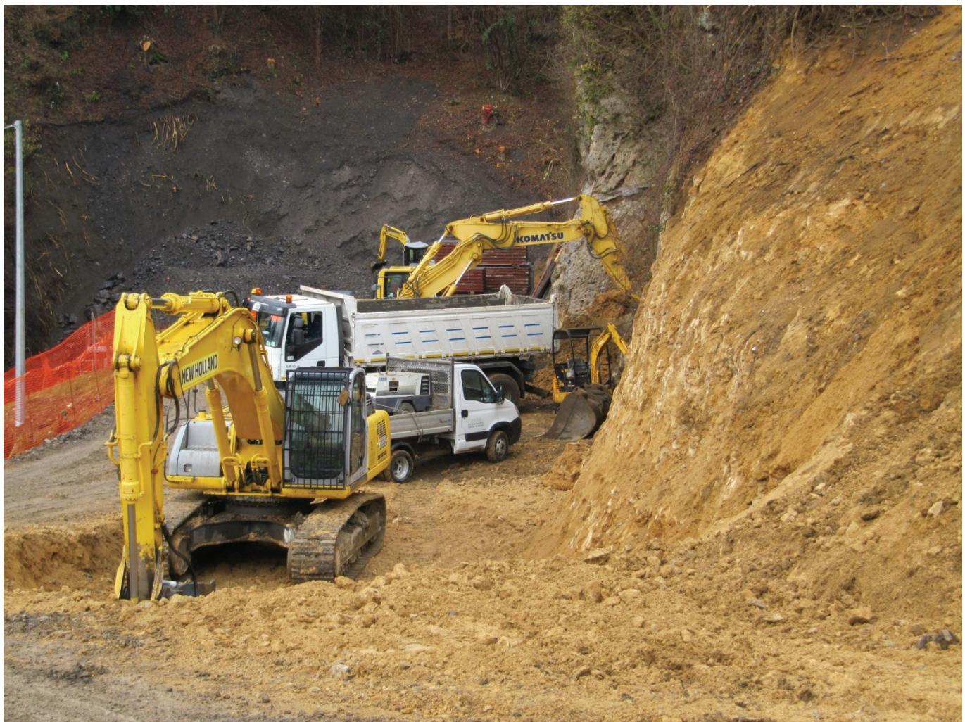
Le opere in corso consistono nel completamento delle spalle del Ponte Inzogno, di uno scatolare di sottopassaggio gettato in opera, di un rilevato in terre armate.
